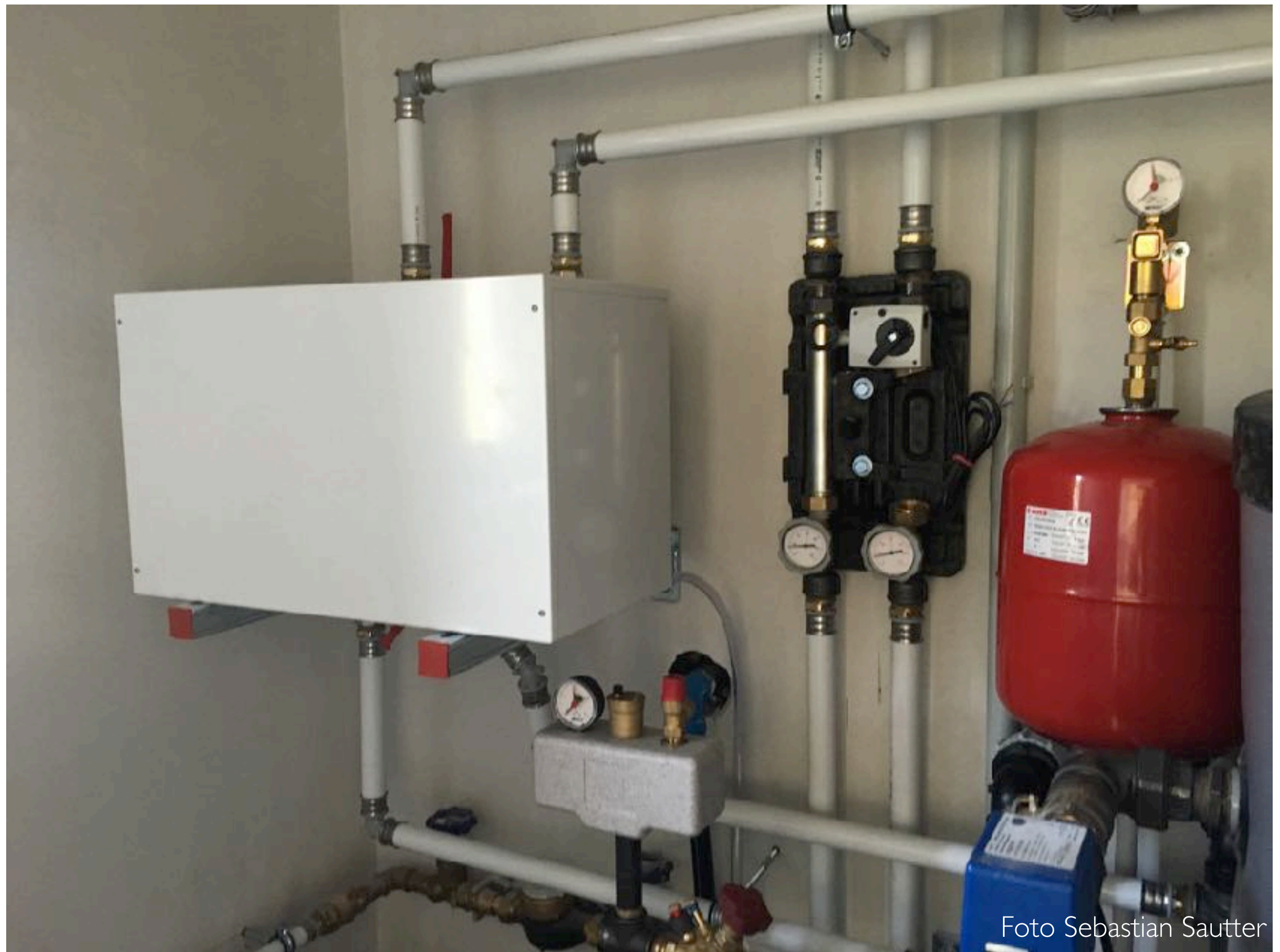
Frischlademodul für Warmwasserbereitung Active House N., ORTLOS, Baustellenfotos
