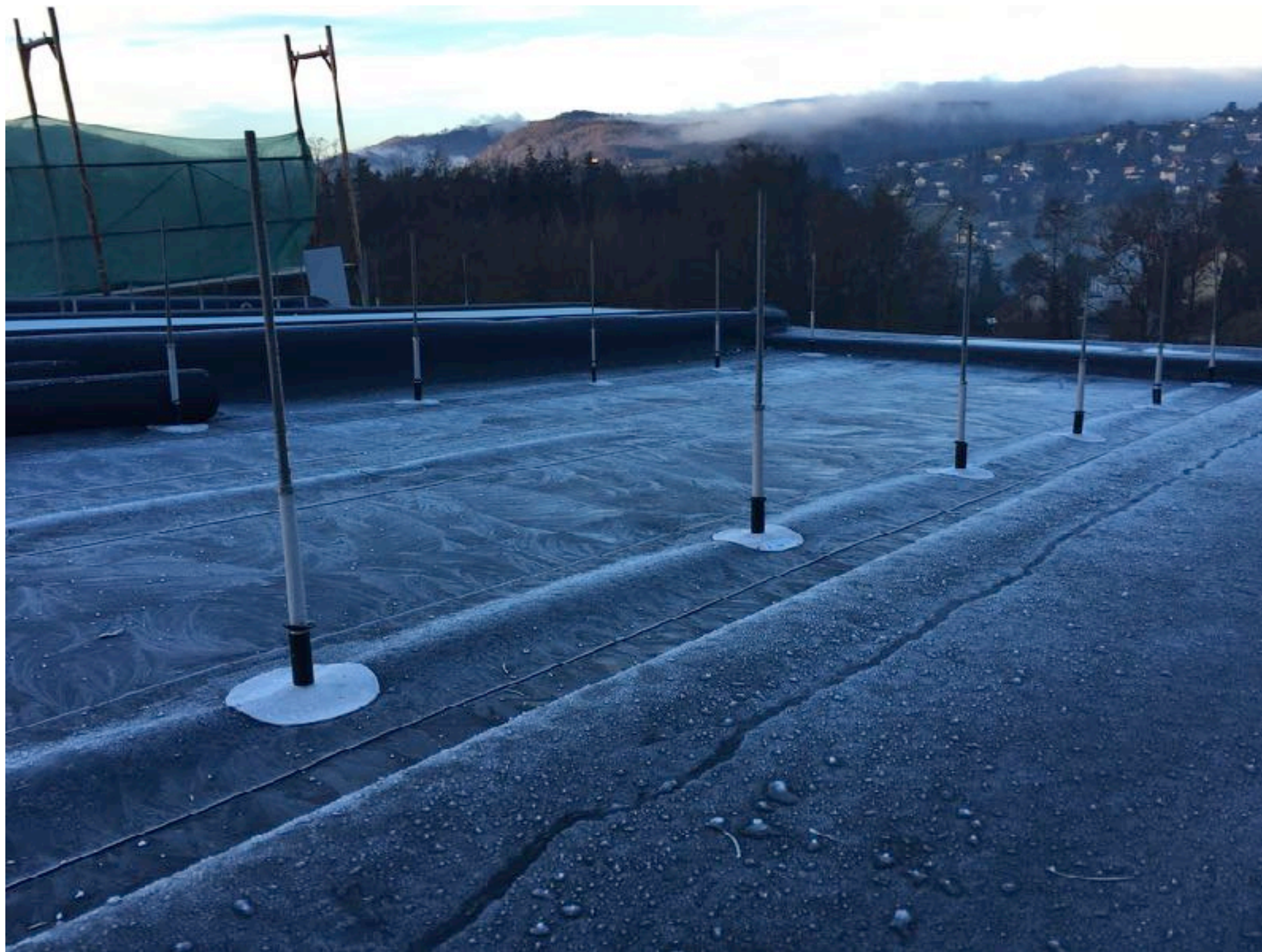
Montage der PV-Anlage, Spitzer Dach, 2015-2016 Active House N., ORTLOS, Baustellenfotos
