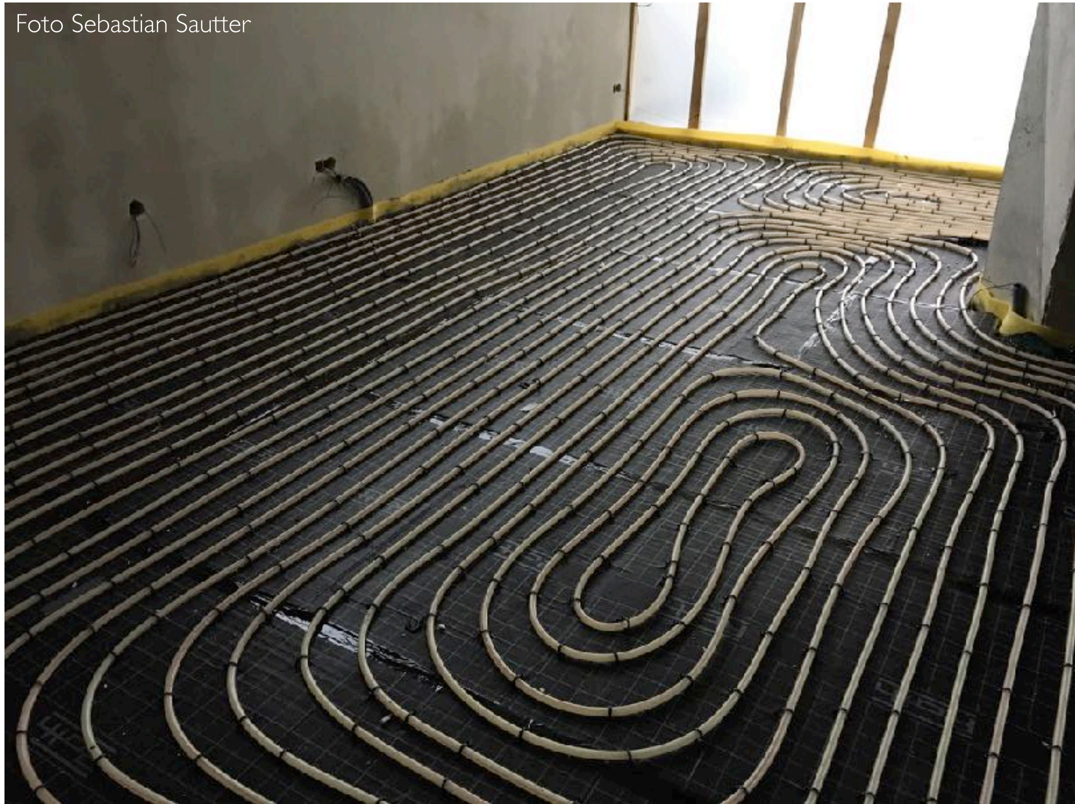
Verlegung Fussbodenheizung Active House N., ORTLOS, Baustellenfotos
